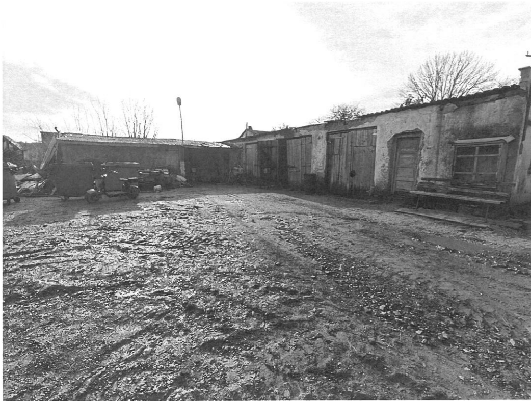
Imagine actualul Parc Auto –Direcția Publică de Gospodărire Comunală – vedere din str. Albăstrelelor – sursa foto: Primăria Oraș Techirghiol
